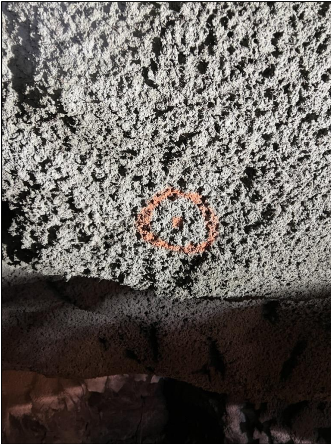
Foto 6. Pel 65, h. side. Eksempel på bom i sprøytebetong. Anbefales boltesikres med 1 stk. 2,4 m bolt
