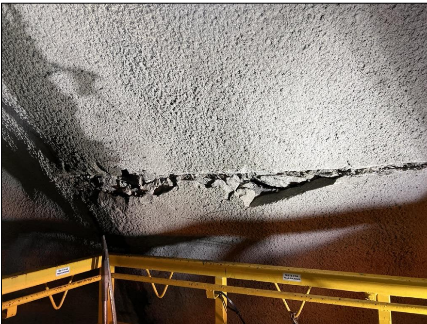
Foto 10. Pel 395 h. side, skade på vann- og frostsikringshvelv, anbefalt å utbedre.
