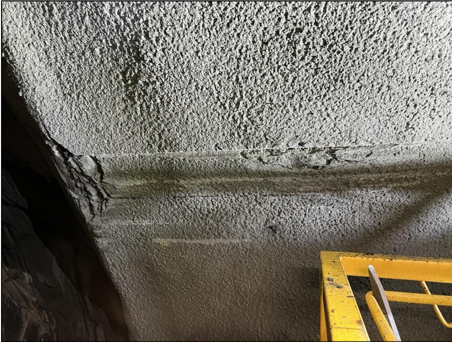
Foto 9. Pel 330 h. side, skade på vann- og frostsikringshvelv.
