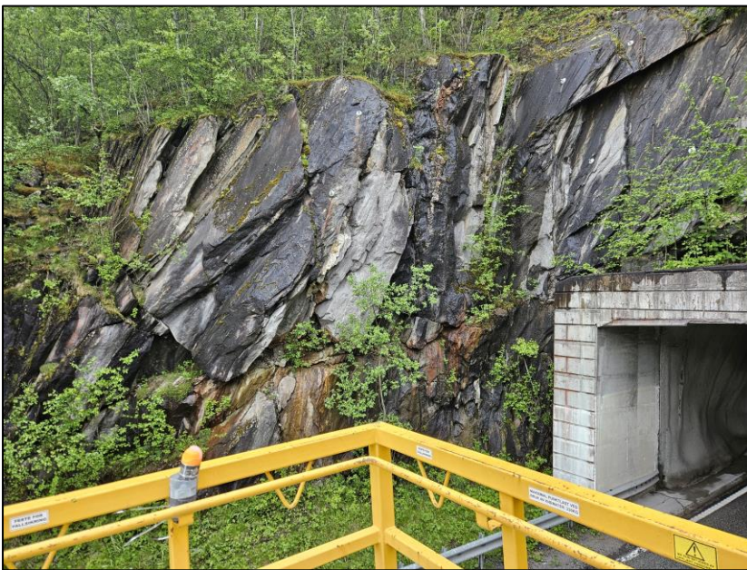
Foto 2. Oversikt portal øst. Det anbefales rensk av berget, samt supplering av boltesikring. Geolog må detaljprosjekttere sikring etter rensk er utført.
