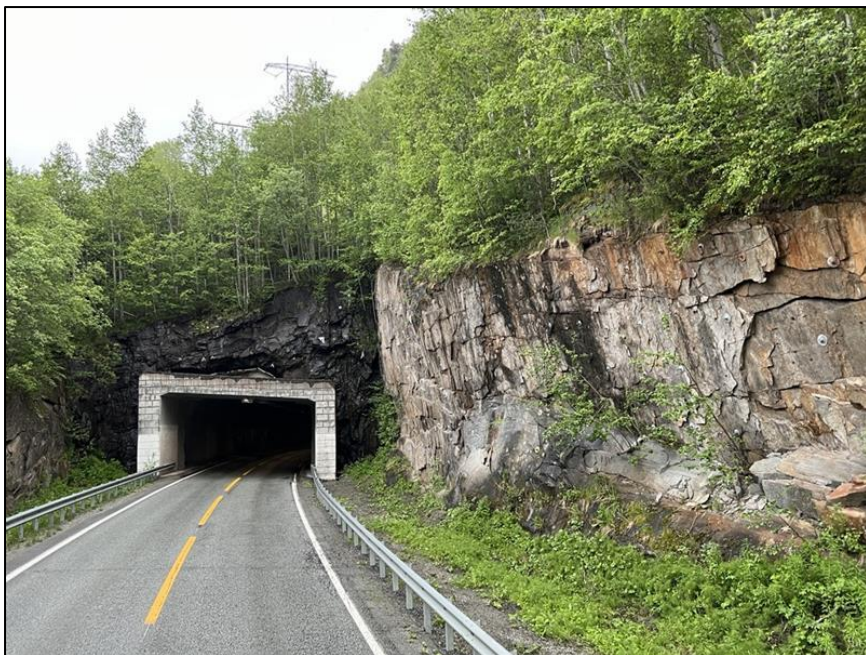
Foto 3. Oversikt forskjæring vest. Berget er småfallent og det anbefales dermed rensk av hele skjæringen samt supplerende boltesikring etter rensk. Geolog må detaljprosjekttere sikring etter rensk er utført.
