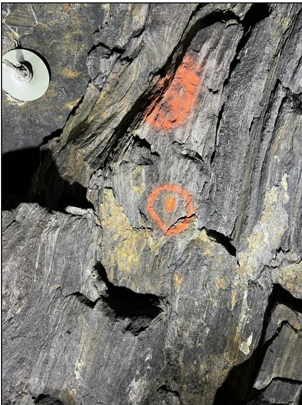
Foto 8. Pel 240 h. side, hastetiltak. Avløst blokk med bom, anbefales å sikres med 1 stk. 2,4 m bolt eller renskes ned.
