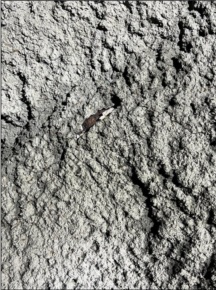
Foto 5. Eksempel på tynn sprøytebetong. Generelt er det flere områder med tynt lag av sprøytebetong og det anbefales å rense ned tynne avløste sprøytebetongflak.
